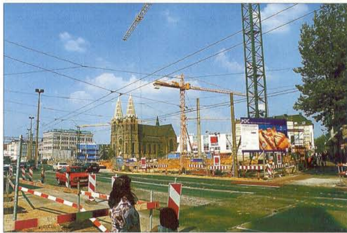
Baustelle der Galerien im Mai 1998, im Hintergrund die Clemens-Kirche
