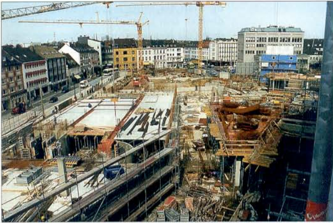
Bau des Hauptgebäudes mit Bücherei und Volkshochschule, Februar 1999
