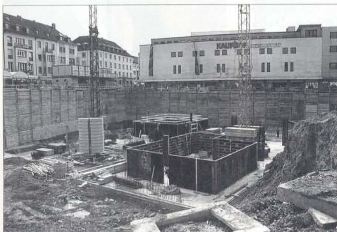
Erste Fundamentarbeiten für die Clemens-Galerien im April 1998
