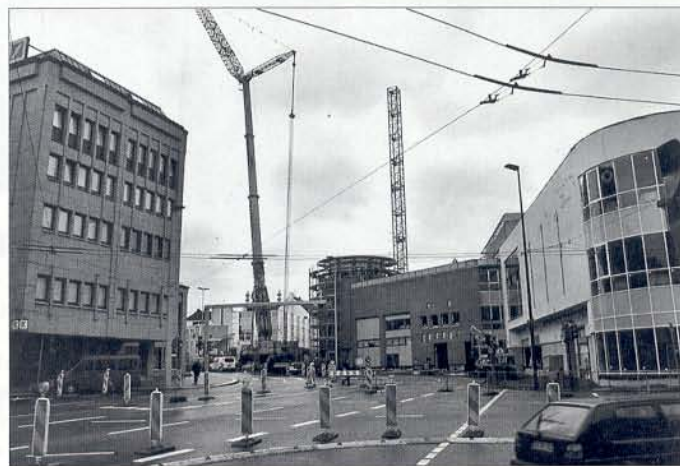
Umbau der Mummstraße im Juni 1998
