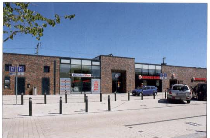
Das neue Empfangsgebäude mit Mobilitätszentrale, Kiosk und Schnellrestaurant. Links am Gebäude erkennbar ein Geldautomat, daneben eine behindertengerechte Toilette. Über dem Haupteingang in der Mitte des Gebäudes fehlt noch ein beleuchtetes Schild „Bahnhof Norden“. Im Vordergrund sind die Kurzzeit- und Behindertenparkplätze erkennbar, Taxen dürfen rechts im Vordergrund und direkt vor dem Gebäude halten. Aufnahmen ohne Vermerk: C. Walther
