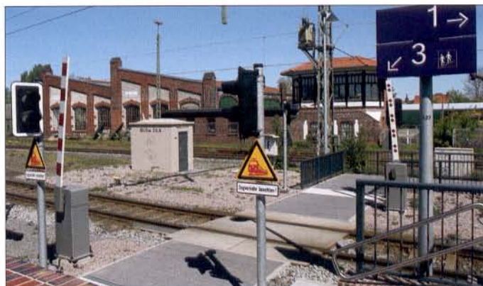
Der ebenerdige und behindertengerechte Übergang von Gleis 1 zu Gleis 3 wurde beibehalten und in nördlicher Richtung verlegt. Eine Unter- oder Überführung wäre deutlich teurer gewesen und stellte sich aufgrund der mittleren Zugdichte als nicht notwendig heraus. Das automatische Schließen und Öffnen der Schranken ist mit einer optischen und akustischen Signalanlage gekoppelt.
