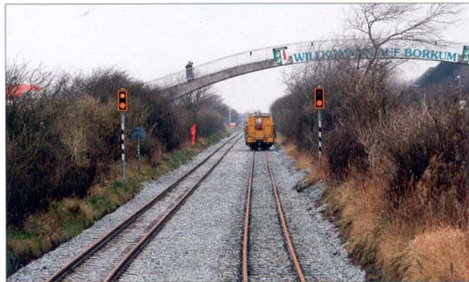
Gleis 1 (links) ist nach Einbau der drei Softbeton-Testabschnitte optisch nicht von einer herkömmlichen Eisenbahnstrecke zu unterscheiden. Bis Mitte Mai soll auch das rechte Gleis 2 fertiggestellt sein. Aufnahme: C. Walther
